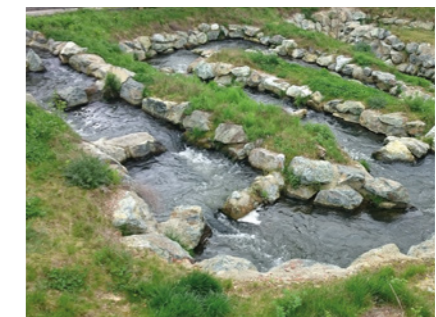
Fischaufstieg am Kraftwerk „Mattesmühle“ an der Feistritz in Dobersdorf
